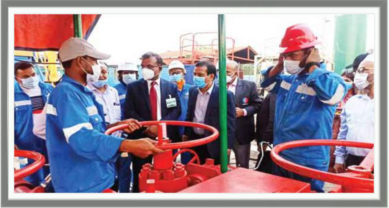
শ্রীকাইল ইস্ট-১ কূপের খনন কার্যক্রম পরিদর্শন করছেন জ্বালানি ও খনিজ সম্পদ বিভাগের সিনিয়র সচিব
