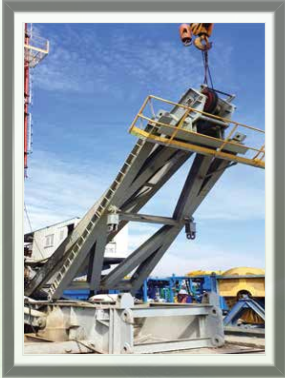
কূপ খননের লক্ষ্যে রিগ আপ কার্যক্রম
